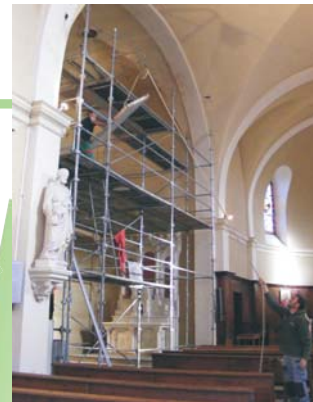
Installation de l'échafaudage
