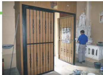
Pose de la grille
